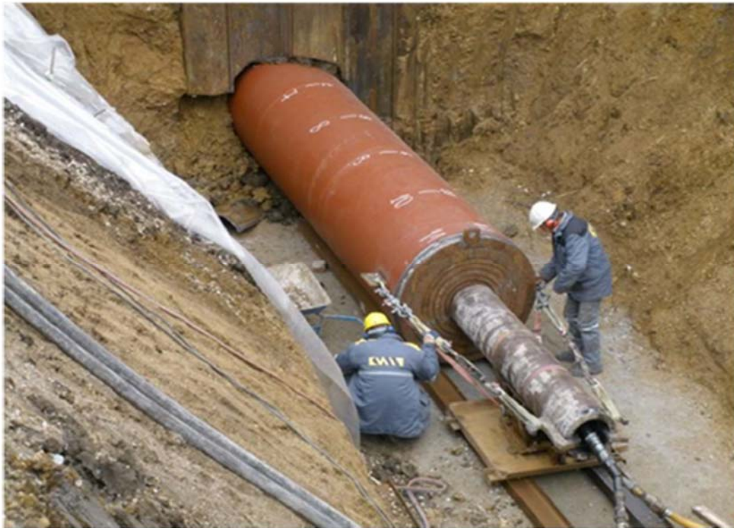
ФИГУРА 21. ИЗПЪЛНЕНИЕ НА ХОРИЗОНТАЛЕН СОНДАЖ ЧРЕЗ ПНЕВМАТИЧЕН ЧУК
