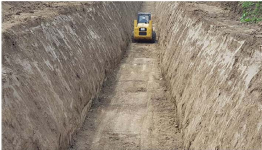
ФИГУРА 13. ПОДРАВНЯВАНЕ НА ДЪНОТО НА ТРАНШЕЯТА
