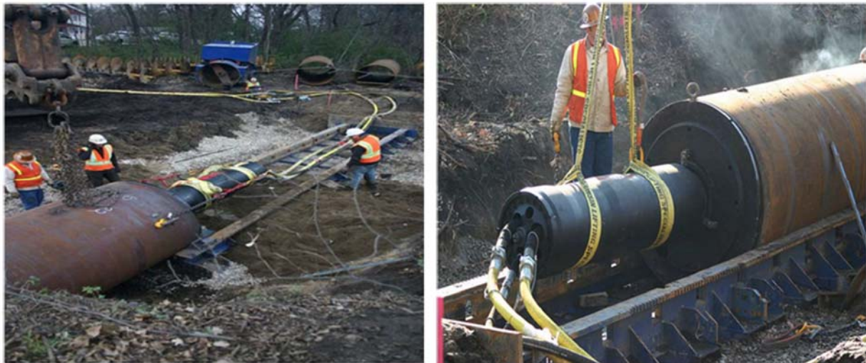
ФИГУРА 19. НАБИВАНЕ С ПНЕВМАТИЧЕН ЧУК
